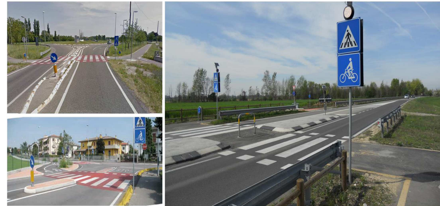
FIGURA 58 ATTRAVERSAMENTO CON ISOLA CENTRALE SALVAGENTE (LA PRESENZA DI ARCHETTI E PALETTI OLTRE L'ATTRAVERSAMENTO RAPPRESENTA UN ELEMENTO DI PERICOLOSITÀ E DIFFICOLTÀ DI PASSAGGIO PER I MEZZI PIÙ INGOMBRANTI COME BICI CON CARRELLO, TANDEM ETC.)
