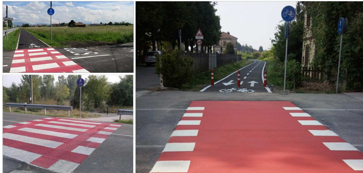
FIGURA 57 ATTRAVERSAMENTO CICLABILE SEMPLICE (LA PRESENZA DI ARCHETTI E PALETTI OLTRE L'ATTRAVERSAMENTO RAPPRESENTA UN ELEMENTO DI PERICOLOSITÀ E DIFFICOLTÀ DI PASSAGGIO PER I MEZZI PIÙ INGOMBRANTI COME BICI CON CARRELLO, TANDEM ETC.)
